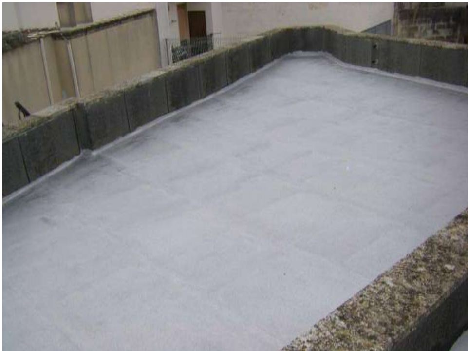
FOTO COPERTURA POST OPERAM
