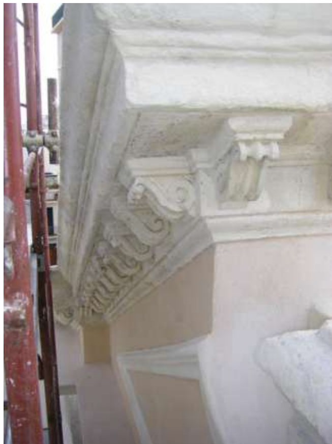
FASI DI LAVORAZIONE
