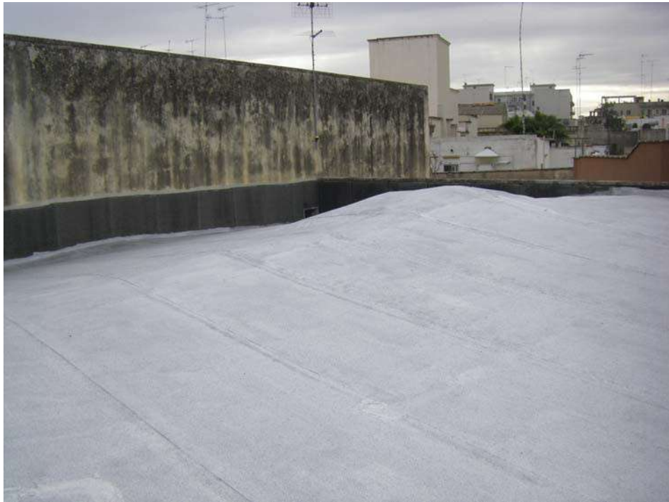
FOTO COPERTURA POST OPERAM
