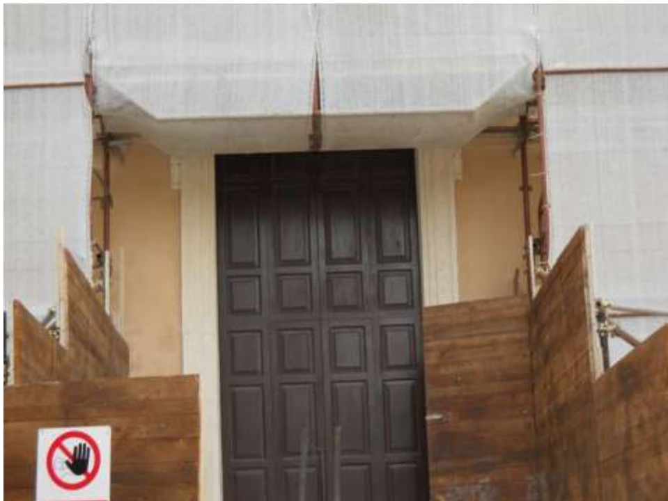
FASI DI LAVORAZIONE
