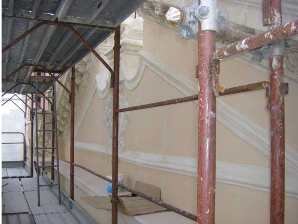
FASI DI LAVORAZIONE
