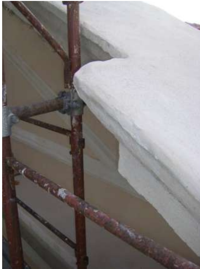
FASI DI LAVORAZIONE
